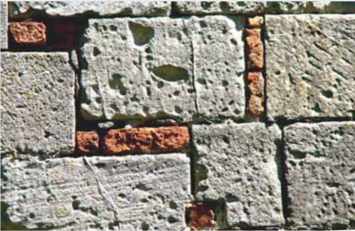
Bedemgrad, kraj 13. početak 14. st. – prizemlje zapadnoga zida ulazne kule, lice zida od klesanaca kamena pješčenjaka, cjelovitih i prelomljenih opeka
